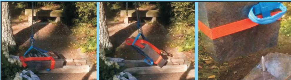
5. Wenn sie unseren Meistergurt (nur mit Betriebserlaubnis zu verwenden) benutzen, können sie nun den Stein unproblematisch und rückschonend aufrichten und über dem Dübel mit aufgesteckter Hülse positionieren und aufsetzen.
