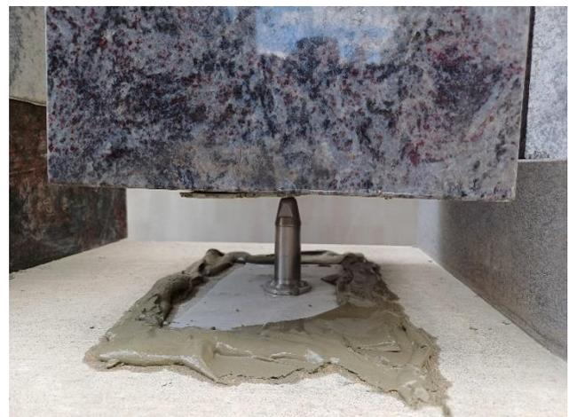
Bild 4: Standfuge aus Zementmörtel für Grabmal 3
