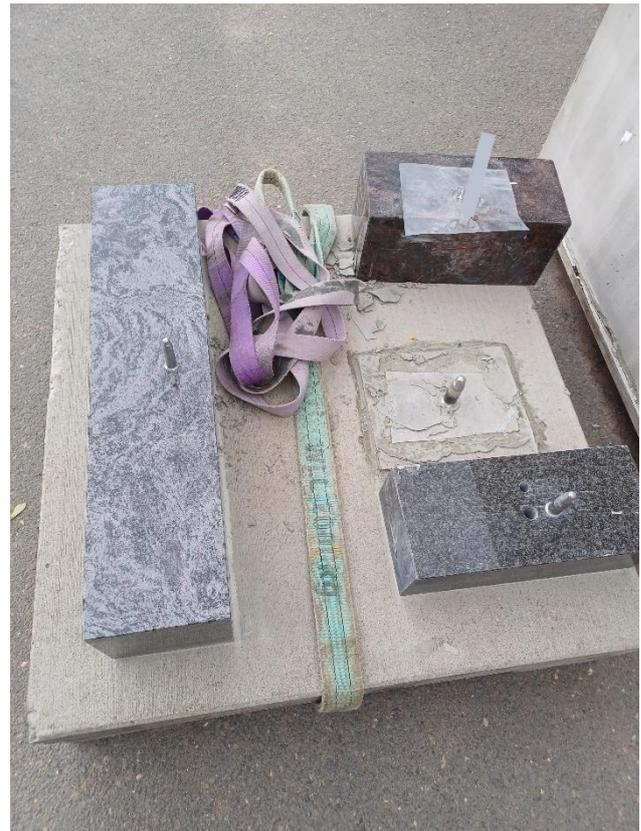
Bild 2: Fundamentplatte mit Sockeln und montierten Anker/ Dübeln
